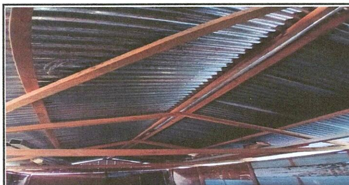
Foto 5: Instalación de estructura de techo y cubierta de láminas calibre 26
